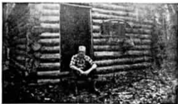
Le camp de chasse du lac Croche. Les chaînes dans la fenêtre, retenues par des clous de six pouces, visent à prévenir la visite des ours.
