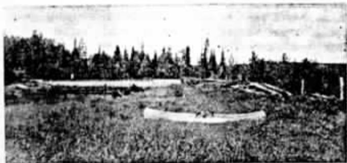
Le barrage Gilardo, qui sert de pont sur la rivière Vermillon, pour se rendre au lac Ottawa et au lac Croche.
